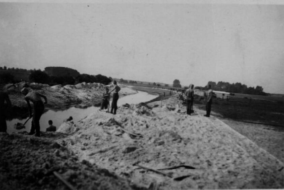
Fotos des RAD 1/96 von Arbeiten am Kanal bei Damm
